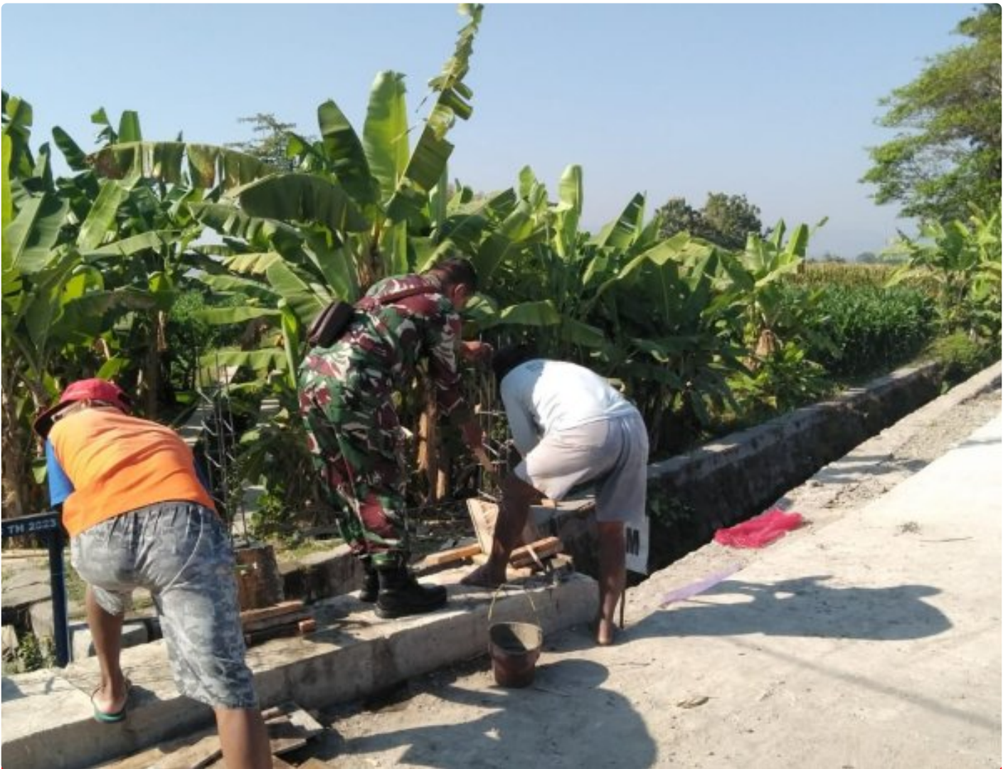
Tahap Finising Jembatan TMMD Reg 121 Kodim Klaten
